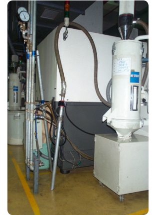
MONTAJE EN LÍNEA DE UNIDADES DE SUCCIÓN
